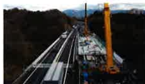
大型クレーンによる全断面施工（従来）
