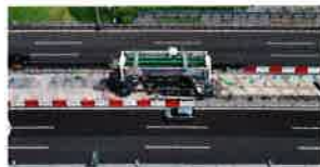
移動床版架設機を用いた現況車線確保による施工（イメージ）
