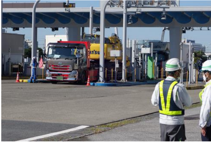
①【東日本高速道路(株)】習志野本線料金所
