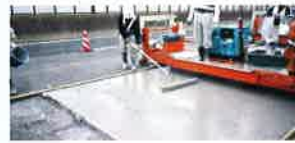
SFRC施工状況
