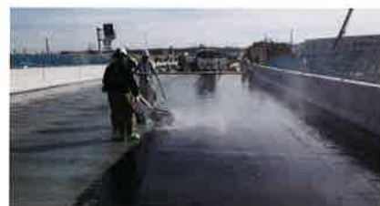
床版防水工施工状況
