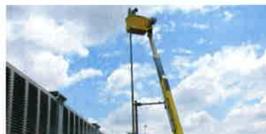
道路照明設備の点検
