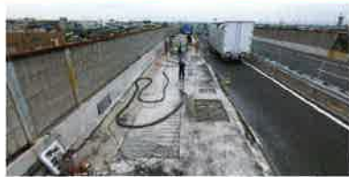
舗装・床版補修状況
