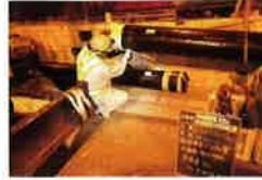
水路管の取替作業状況
