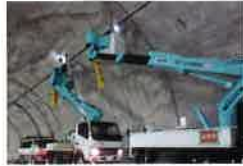
水噴霧設備の設置作業状況
