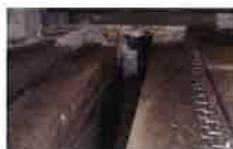
2.橋梁伸縮装置の撤去後の状況
