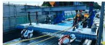
床版架設機による分割した床版取替
