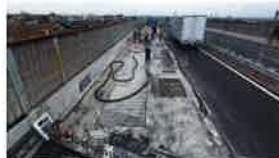
床版補修状況
