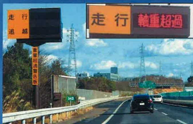
高速道路本線での「軸重超過」表示
