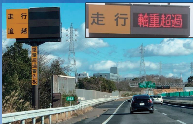
高速道路本線での「軸重超過」表示
