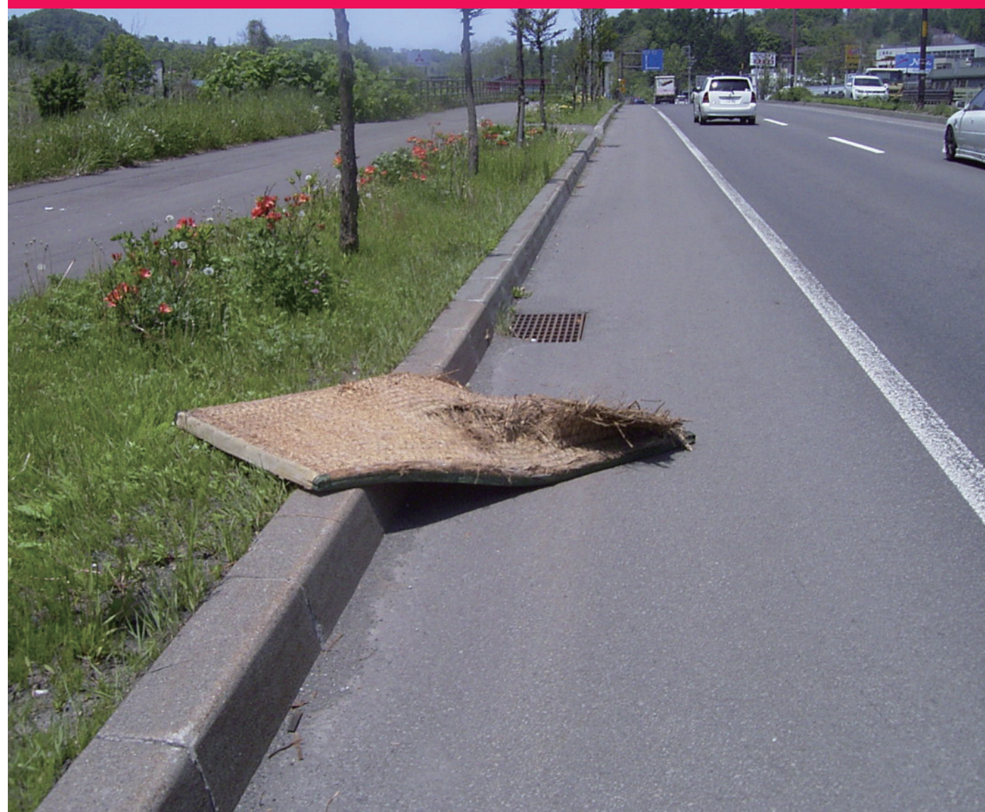
路面の落下物
