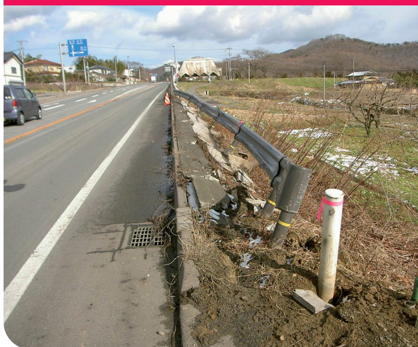
ガードレール・標識等の損傷
