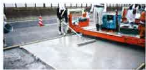
SFRC施工状況
