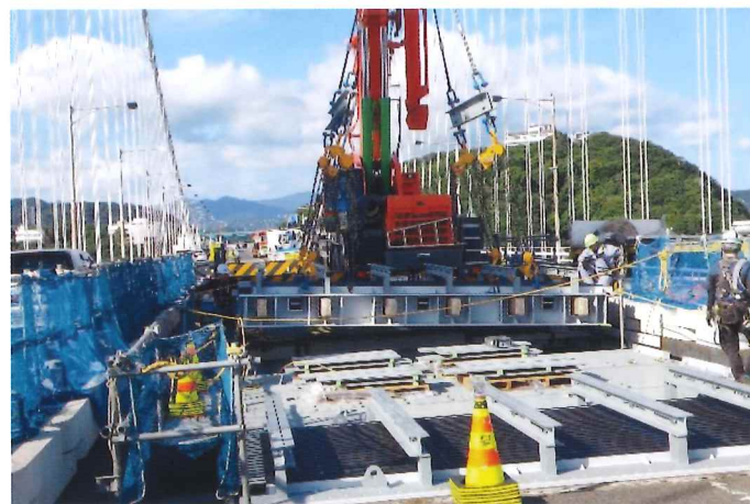
④(新)大型伸縮装置設置作業状況
